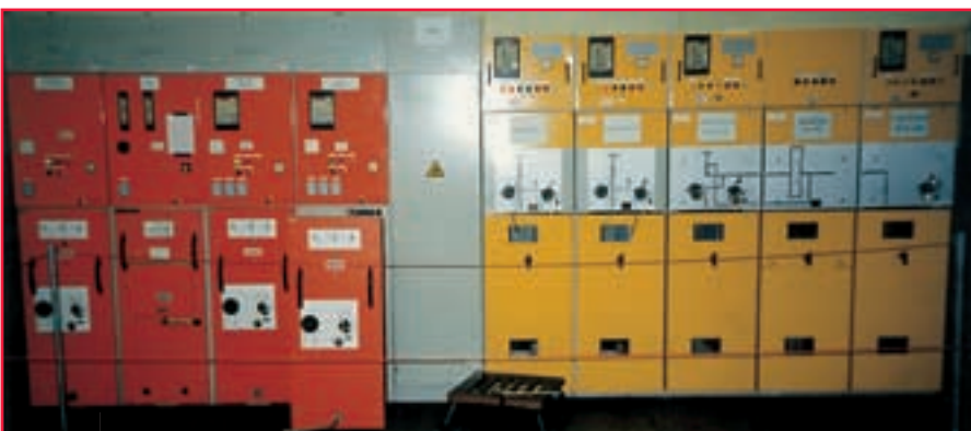
Flexibilité : Raccordement entre gamme Alliance et cellules débrochables
